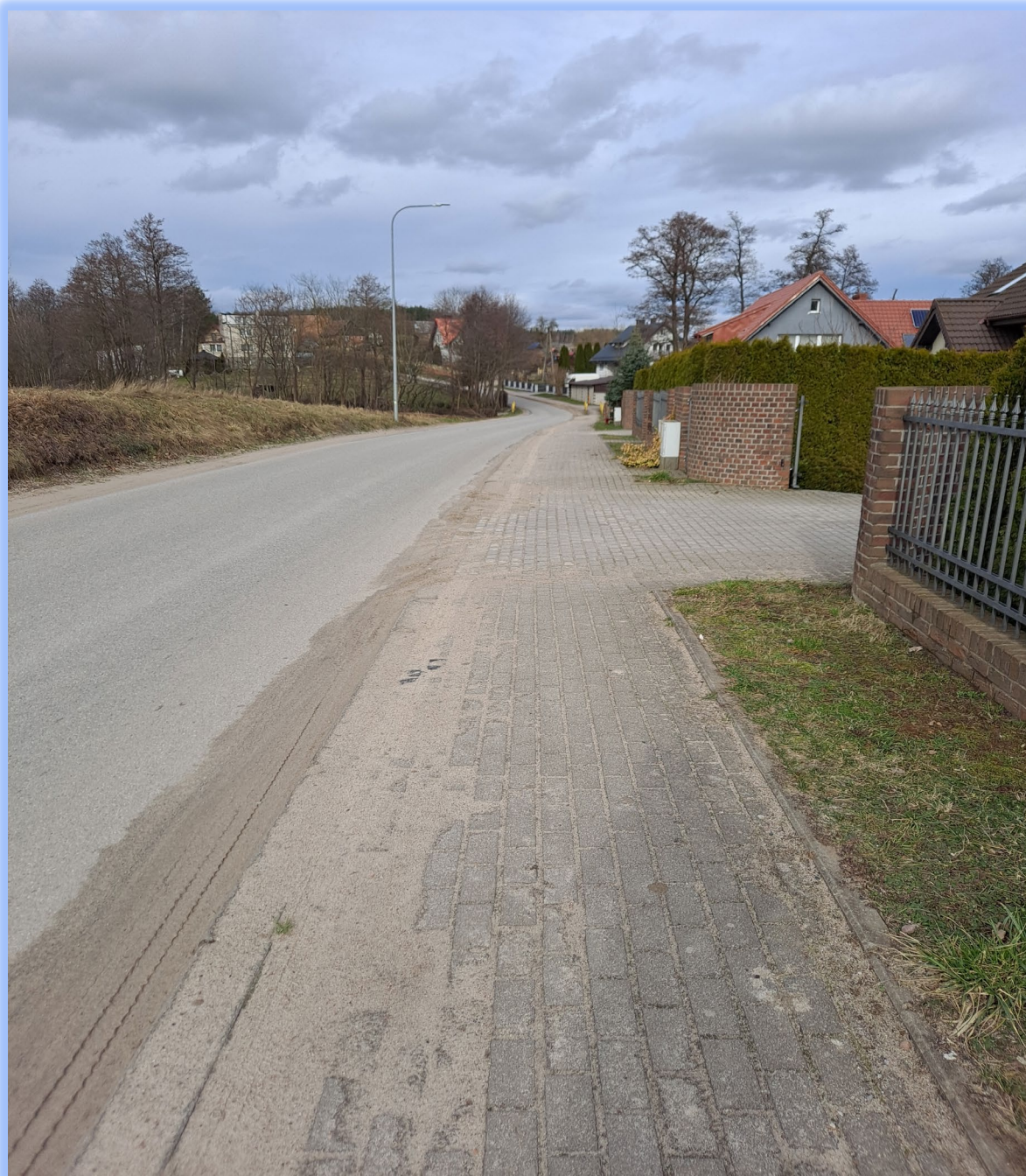
Kosowo – wykonanie chodnika
