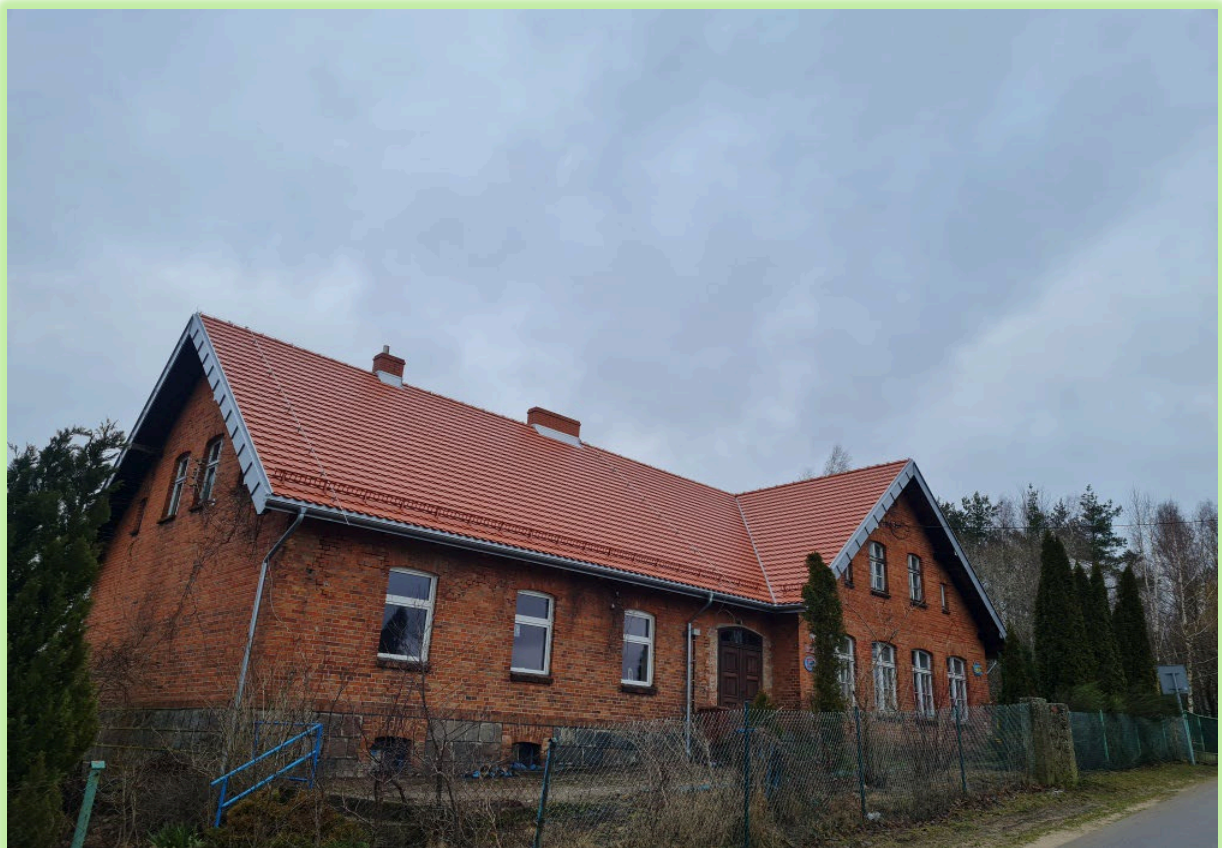
Remont świetlicy w Rębie
